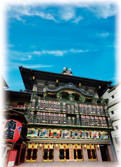
京都の歴史的景観に溶け込んだ桃山風破風造りの近代名建築の外観を維持保存し耐震強化を図ります。
