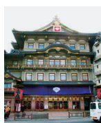
改修工事以前の南座正面外観
